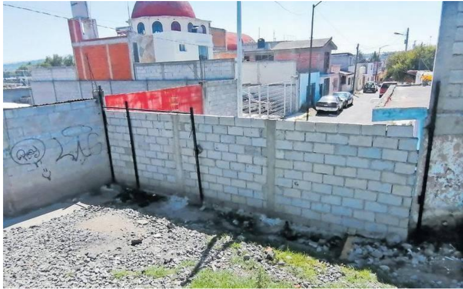
Imagen 7. Muro divisorio en la Tercera Privada de la Colfer
