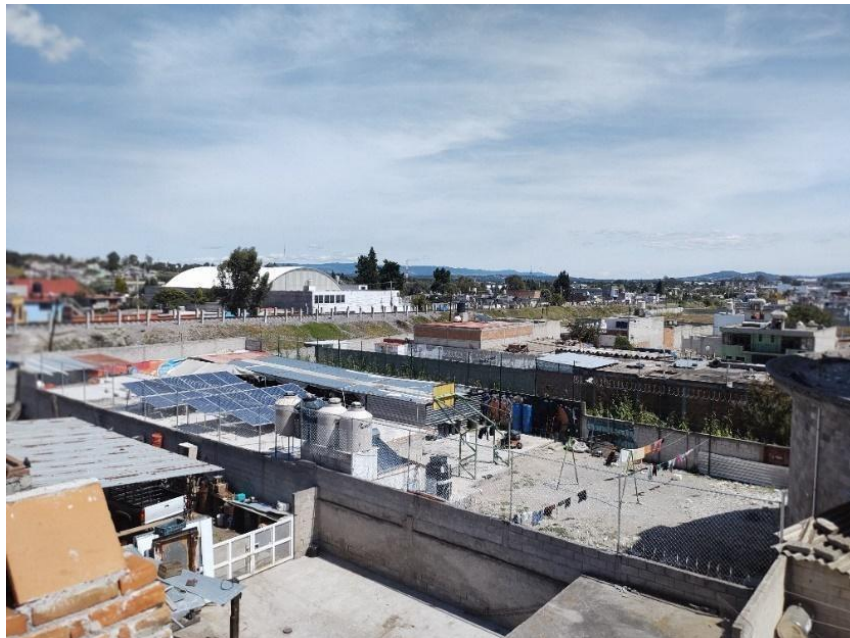
IMAGEN 11. Vista al albergue desde casa de Alejandro
