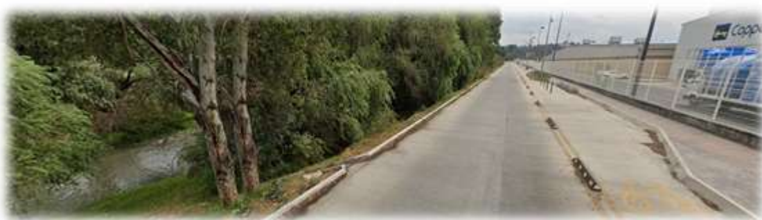
Foto 16 Cicloísta a la altura del centro Comercial Gran Patio
