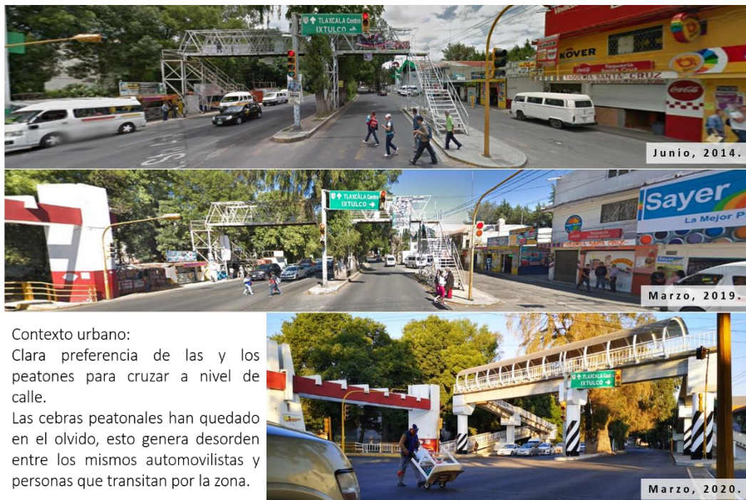
Fotografía 1.3 Remodelación de puente anti peatonal.
