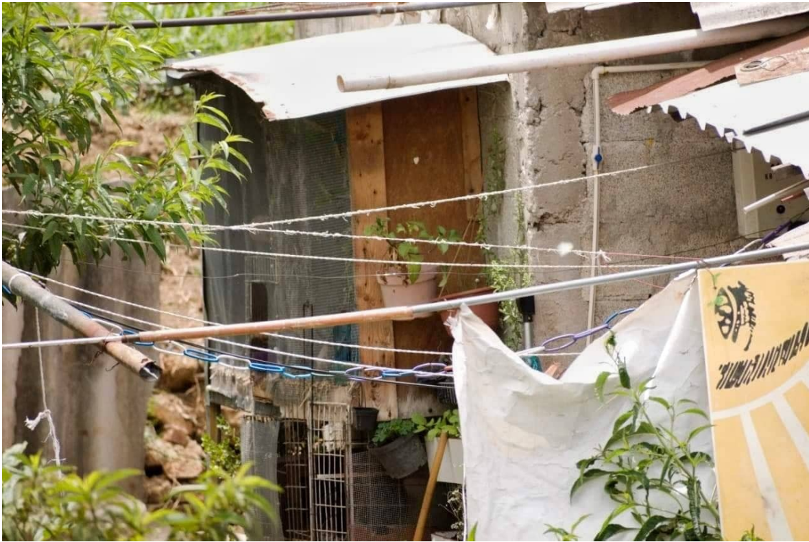
Figura 11. Jaulas divididas y condicionadas para tener gallinas y loros, a un costado de la entrada principal de una vivienda en la ciudad de Tlaxcala, un ejemplo del traslado y adecuación de animales de traspato, del campo a la ciudad. Fuente. Imagen propia
