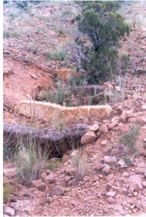
Figura 8. Colocación de barreras de pacas de paca a nivel en barrancas y zonas de escorrentía. Fuente: Archivo encargados del Rancho San Isidro.
