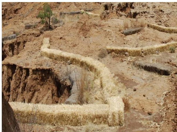
Figura 12. Área sometida a trabajos de restauración. Fuente: Archivo encargados del Rancho San Isidro.
