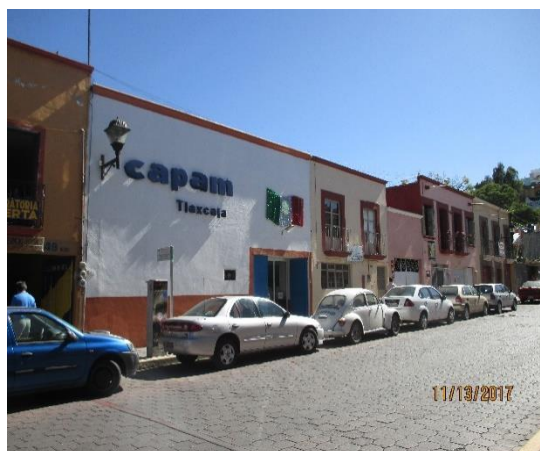
Oficinas de la Comisión de agua potable y Alcantarillado del municipio de Tlaxcala. fotografía tomada el 11 de noviembre de 2017.
