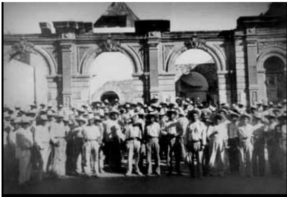
Teatro Xicohténcatl en construcción. Ciudad de Tlaxcala.
